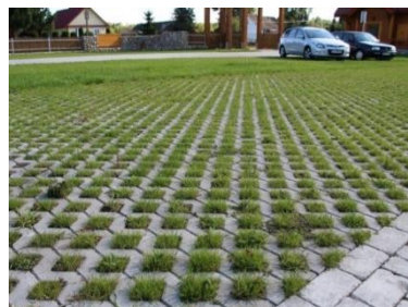
Rozszczelniona powierzchnia parkingu
